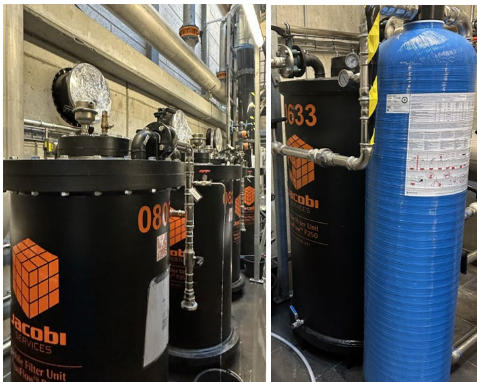
Figur 7: GAC pilotkolonner er AquaFlow P250 (tv) og ionbytterresin, RESINEX pilotkolonne C-1465-A3 (th).
