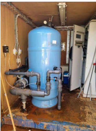
Figur 7: Tv: Foto af 600 L resinbeholder, diameter 0,65 m, flow 11 m 3 /h. Th: Gennembrudskurver for udvalgte PFAS-stoffer og -grupper samt sum af klorerede opløsningsmidler og nedbrydningsprodukter (cVOCs) som funktion af gennemløbne beholdervolumener (Bed Volumes (BV)).
