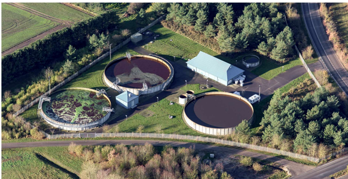
Figur 3 – De to nitrifikationsprocestanke samt udligningstank ved forrenseanlægget
