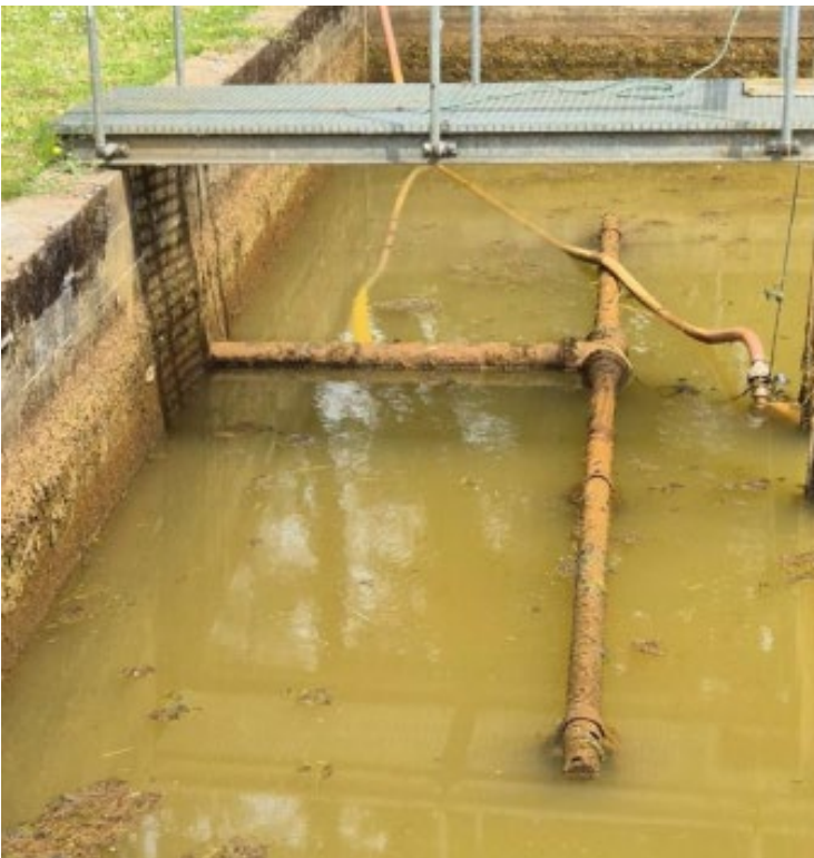
Figur 9 Strengform: Hullet rør parallel til bassinkanten.
