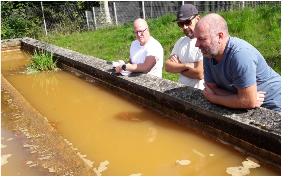
Figur 4 Smalt forkammer til at formindske turbulens og fordele flowet ved indløb af skyllevand.
