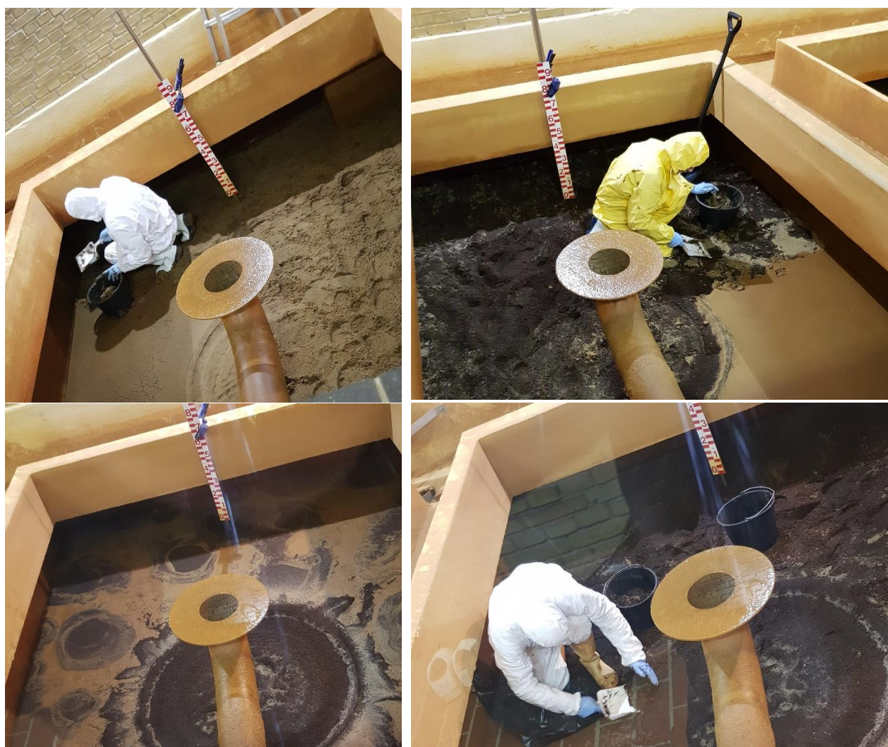
Figur 16 Afskrabning af Filter 2 (Nyt filter, øverst) og Filter 3 (Gammel filter, nederst), efter lidt mere end 2 års drift med blødgøringskolonner. Billeder til venstre er taget før afskrabning og billeder til højre er under afskrabning (foto: HOFOR A/S).
