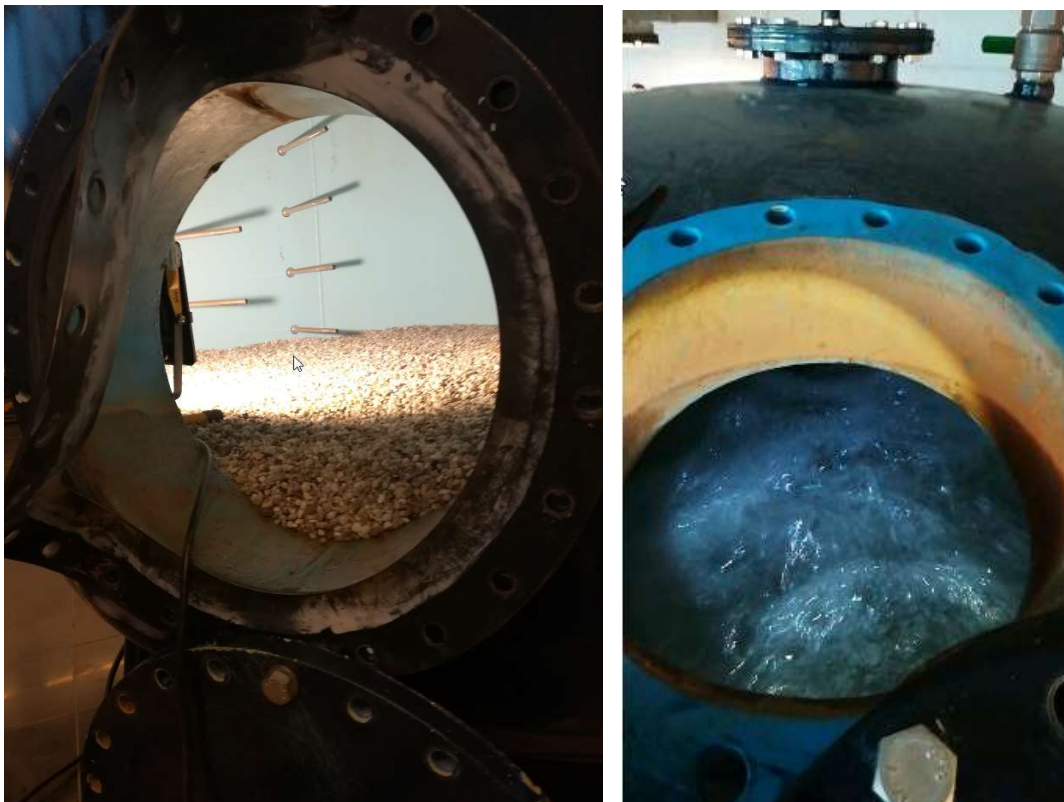
Figur 14 Bærelaget i Smartfilter-Fe (hvor prøvetagningsportene er synlige indefra) og visuel inspektion af skyl med luft (efter øgning af kapselblæserens kapacitet).
