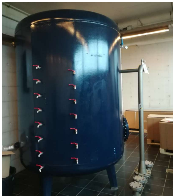
Figur 1 SmartFilter-Fe med prøvetagningshaner for hver 10 cm's filterdybde.
