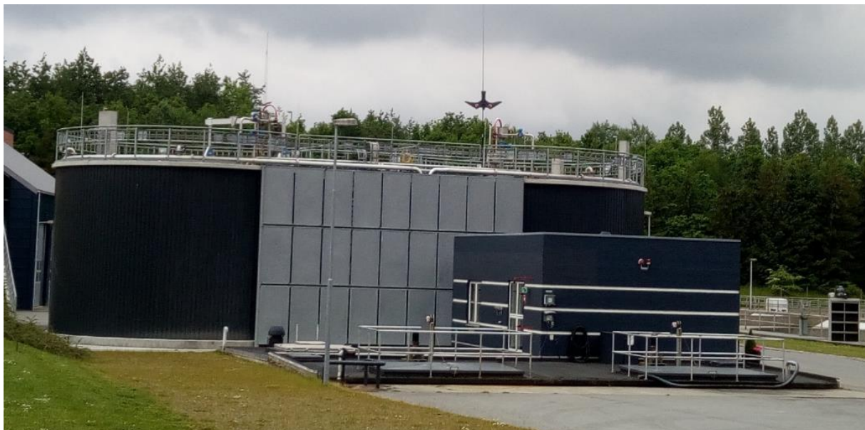
Figure 1 Foto fra Ejby Mølle Renseanlæg af de to DEMON® tank. Hydrocyklonerne kan ses på toppen af tankene med det buede røde rør.
