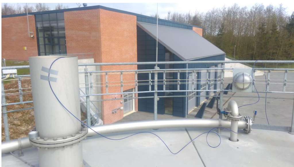
Figure 2 Foto fra toppen af den ene DEMON tank på Ejby Mølle renselanlæg. Den blå slange opsamler gas fra toppen af processen og sender den ned til offgas instrumentet på jorden.
