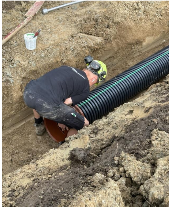
Muffe sættes på røret. Den grønne streg skulle ikke nødvendigtvis pege op ad.
