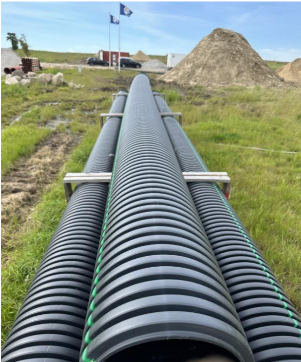
PE-rørene bøjede lidt (bananform). Dansk tradition forskriver lægning af 3 m rør, så rørene blev delt i to.
